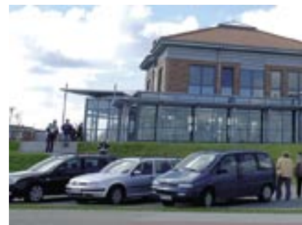
Vor dem Gebäude befinden sich ausreichend Kurzzeitparkplätze für die Kunden
