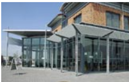
Das Wyker Reedereigebäude der W.D.R.
