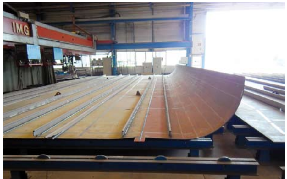
Die ersten Bodenplatten des Neubaus.
